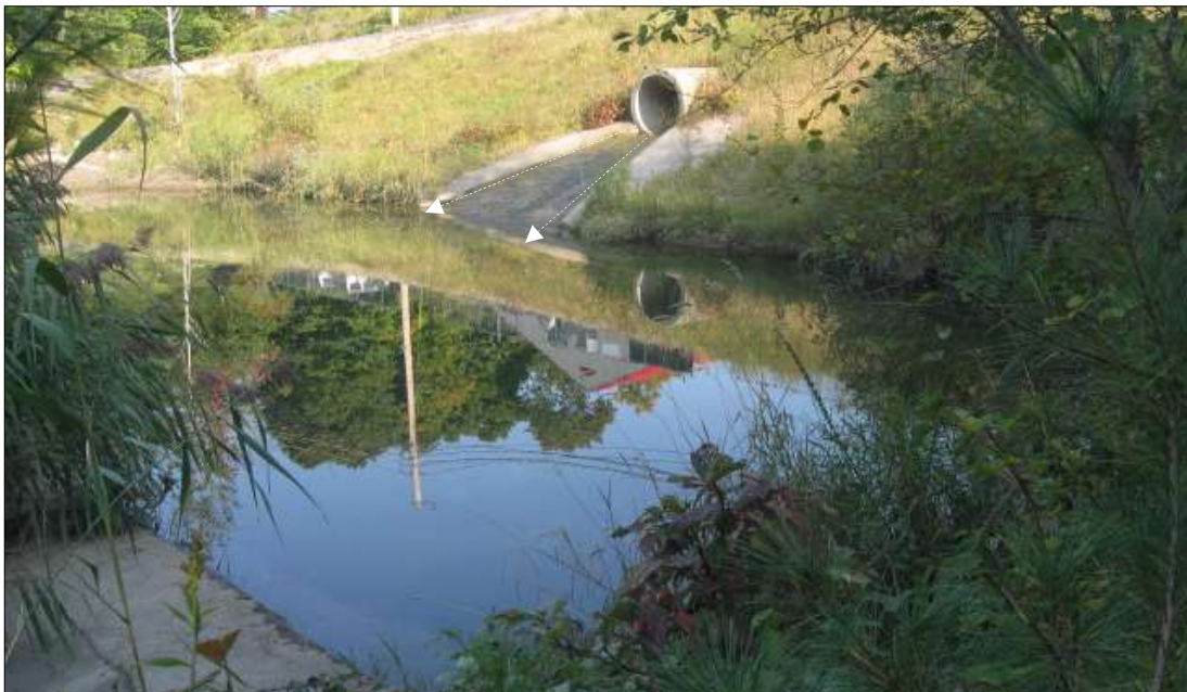
Figure 6.1 Structures d'entrée des eaux pluviales
