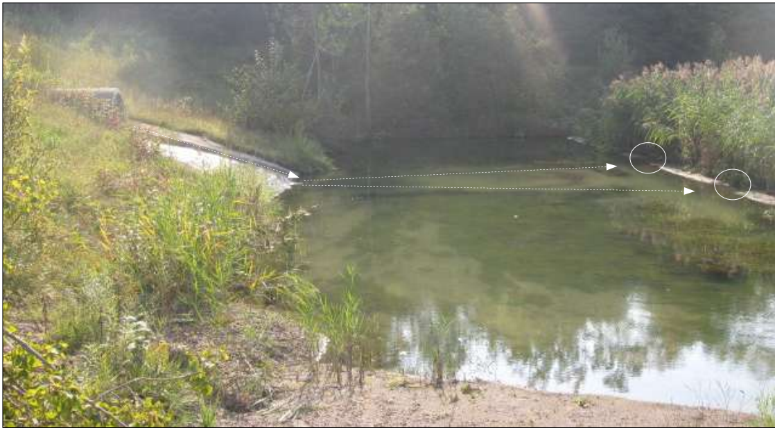
Figure 6.2 Traverse du seuil en deux points uniques
