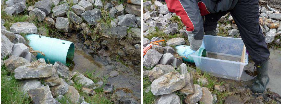
Figure 23 - Sortie du LFA avant et après la mise en place du bac.
