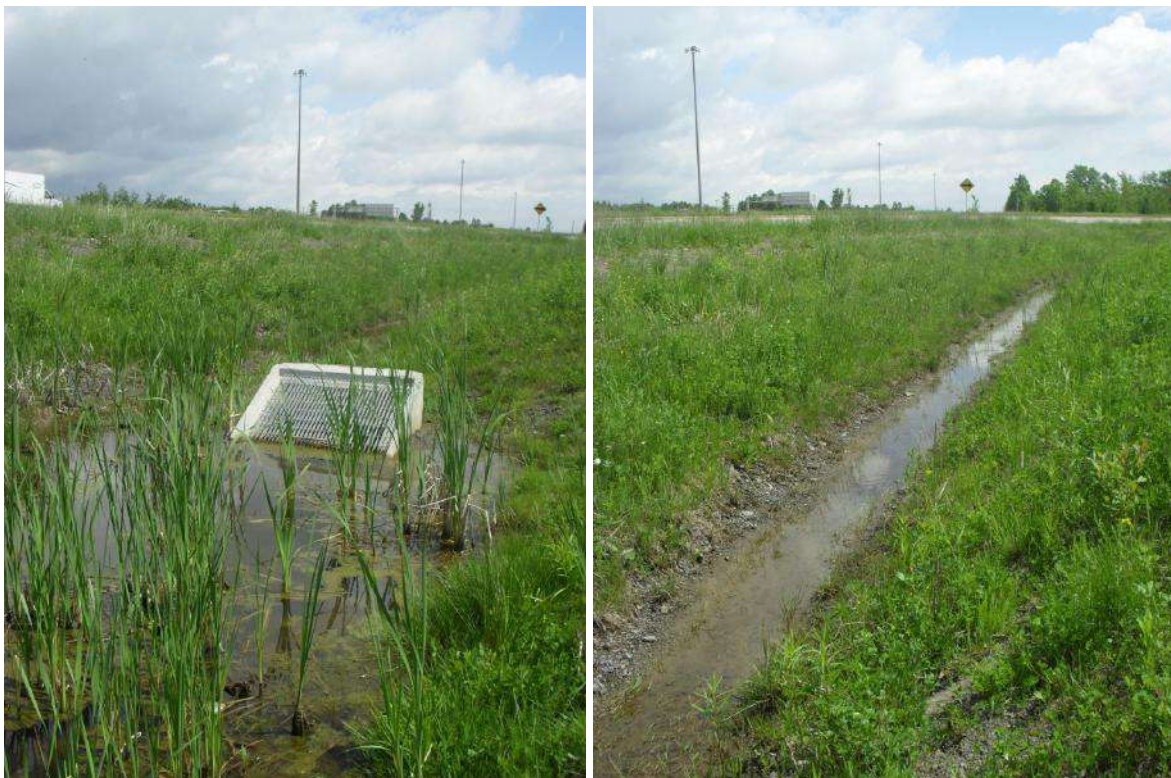
Figure 8 - Entrée du lit filtrant (puisard) et son fossé de trop-plein.
